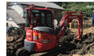
Search and rescue operations using heavy equipment 重機による捜索救助活動
