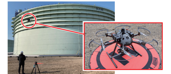
Trial testing oil tank inspection by drones (Tomakomai-Tobu National Petroleum Stockpiling Base) 石油タンクのドローン点検に係る実証実験 (苫小牧東部国家石油備蓄基地において)
